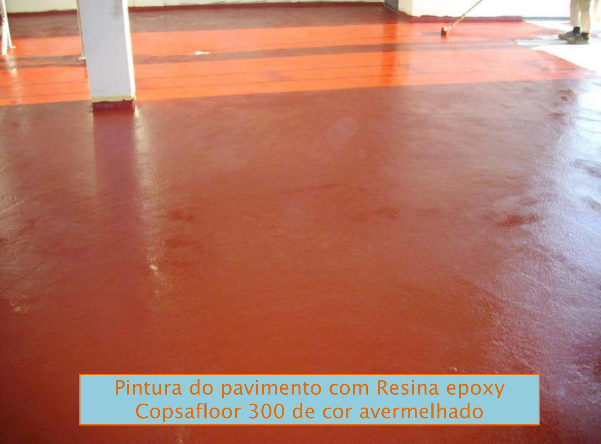
Pintura do pavimento com Resina epoxy
