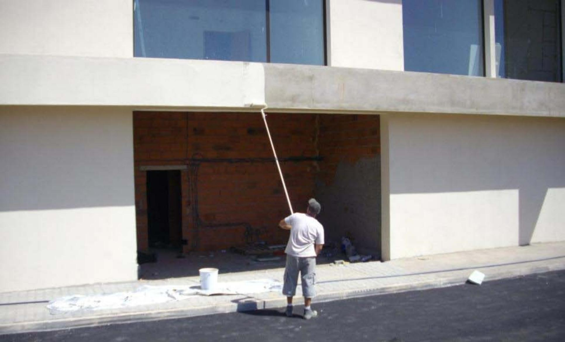
Pintura de alvenarias com tinta Revicolor na cor amarela RAL 9015
